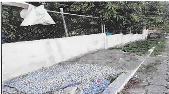
Sustitución de malla en muro perimetral.
