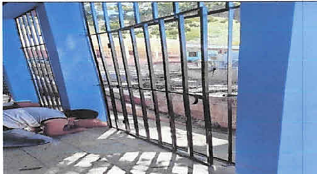
pintura en muros interiores y exteriores.
