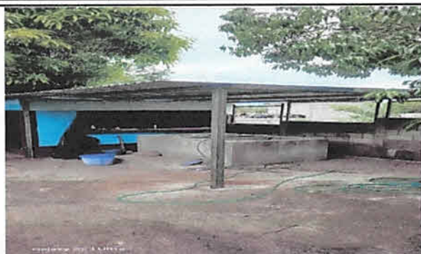
Contrucción de Galera para la pila.
