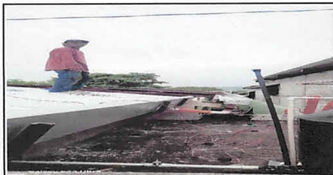
Sustitución de canal y bajadas para agua pluvial.
